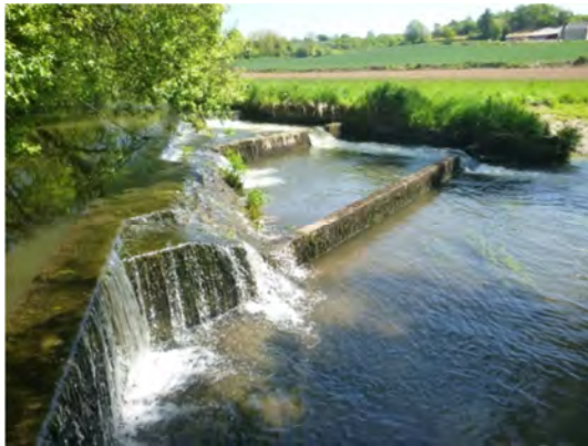
Vue de l'ouvrage de répartition et de la passe à poissons
