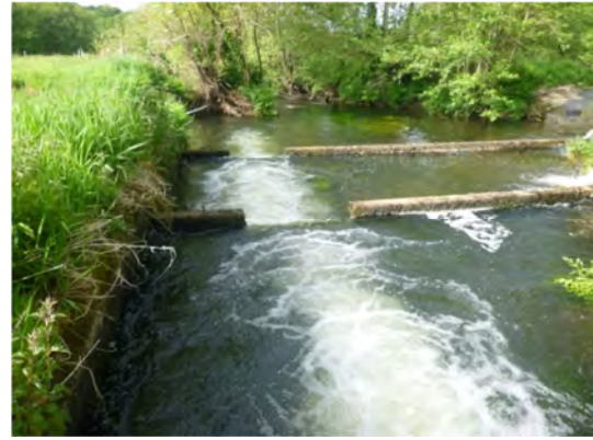
Vue des bassins central et aval
