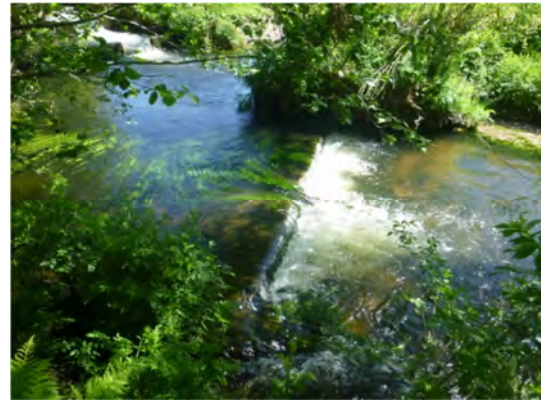
Vue du seuil de stabilisation à l'aval depuis la rive droite
