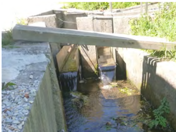
Chute à l'aval des deux goulottes sur une surface bétonnée
