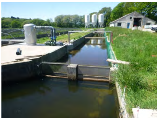
Vue de la grille à l'entrée de la pisciculture (aval des effeuilleuses rotatives)
