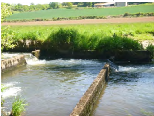
Vue des 2 dernières chutes depuis la rive droite
