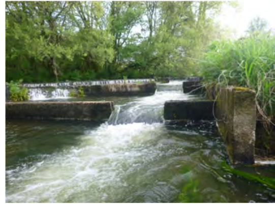
Vue aval de la 3 ème chute
