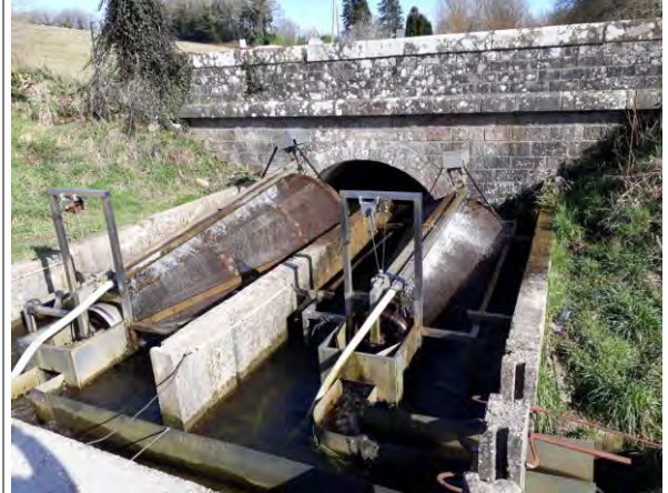
Aérateurs de surfaces dans les bassins
