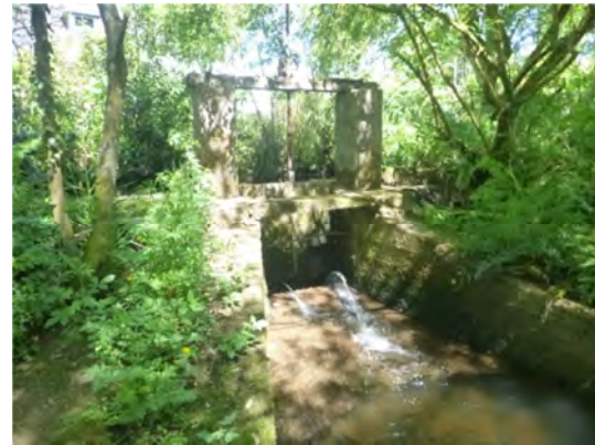
Vue aval de la vanne de décharge amont du bief
